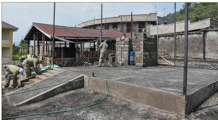
Construcción de incinerador en hospital provincial. Foto: URUBATT.
