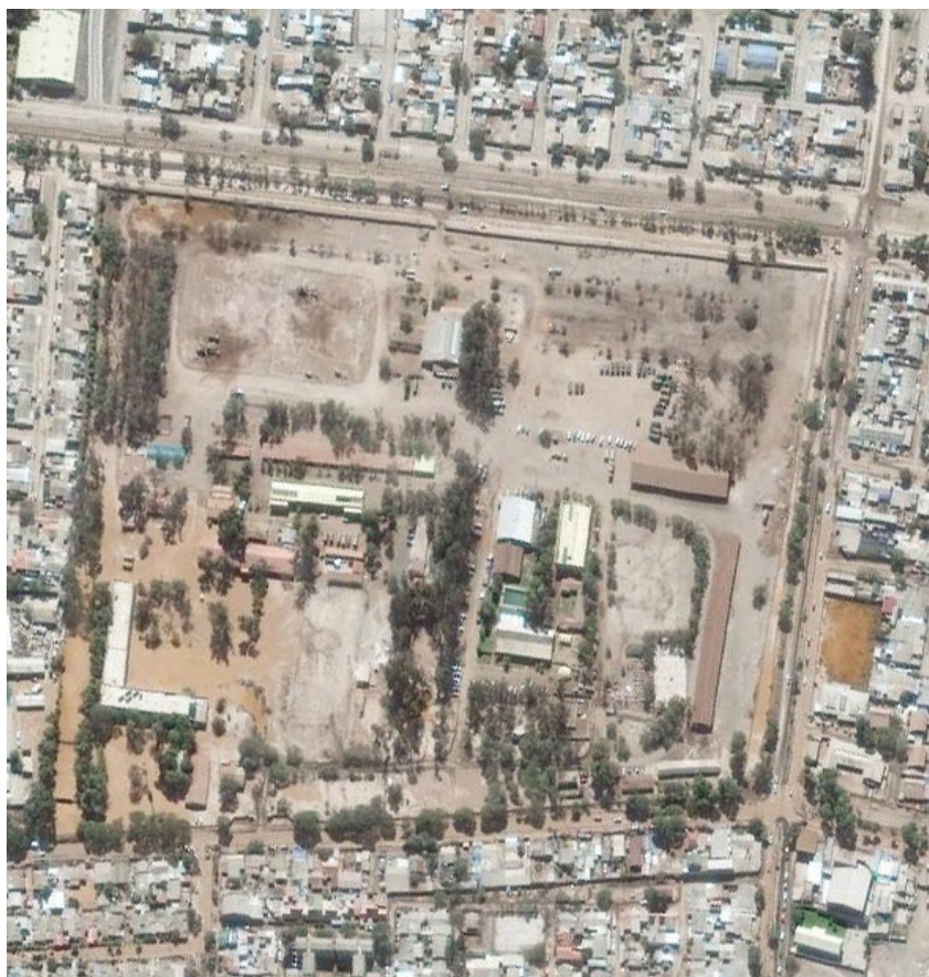
Regimiento de Infantería N.º 23 "Copiapó" (ampliación fotografía satelital IGM), donde se aprecia la inundación del sector sur oeste de la unidad.
