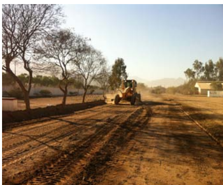
Trabajos de ingenieros.
